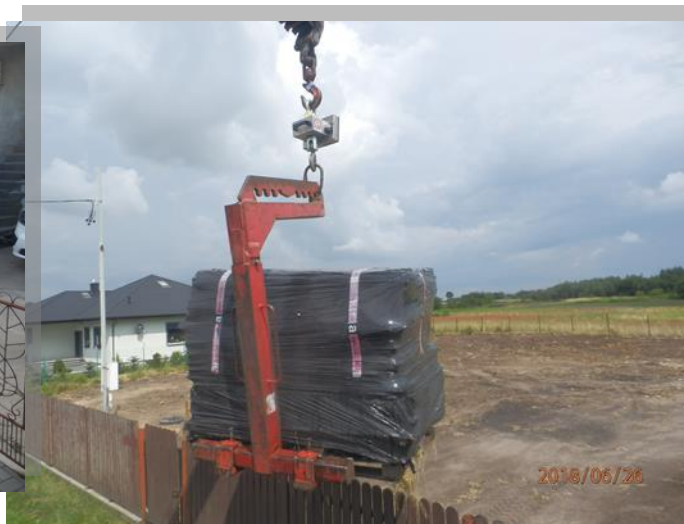
Odbiór odpadów azbestowo- cementowych z terenu Miasta Płocka, ul. Cedrowa
