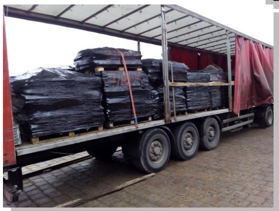
Przeładunek odebranych odpadów cementowo- azbestowych
