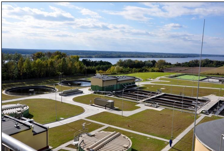
Fot. 6.8 Oczyszczalnia ścieków w Maszewie [195]
