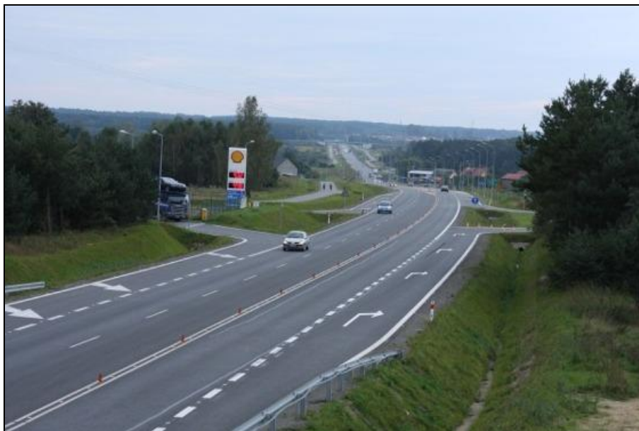
Fot. 6.8 Obwodnica Gostynina w ciągu drogi krajowej nr 60 http://www.gddkia.gov.pl/userfiles/articles/b/budowa-obwodnicy-gostynina---prz_6408//documents/gostynin.pdf
