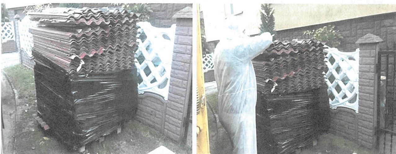
Demontaż azbestu z terenu Miasta Płocka
